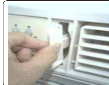
Imagen 3: Ventila y Escape Abiertos
